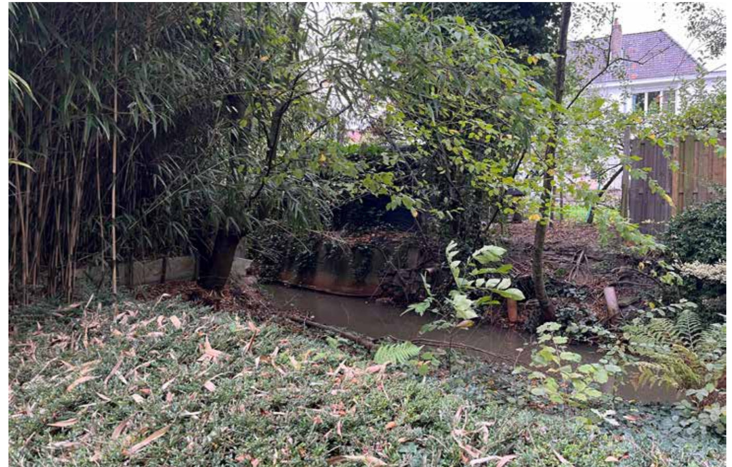
Verharde bedding en waarschijnlijk uitgediepte bedding van waterloop
