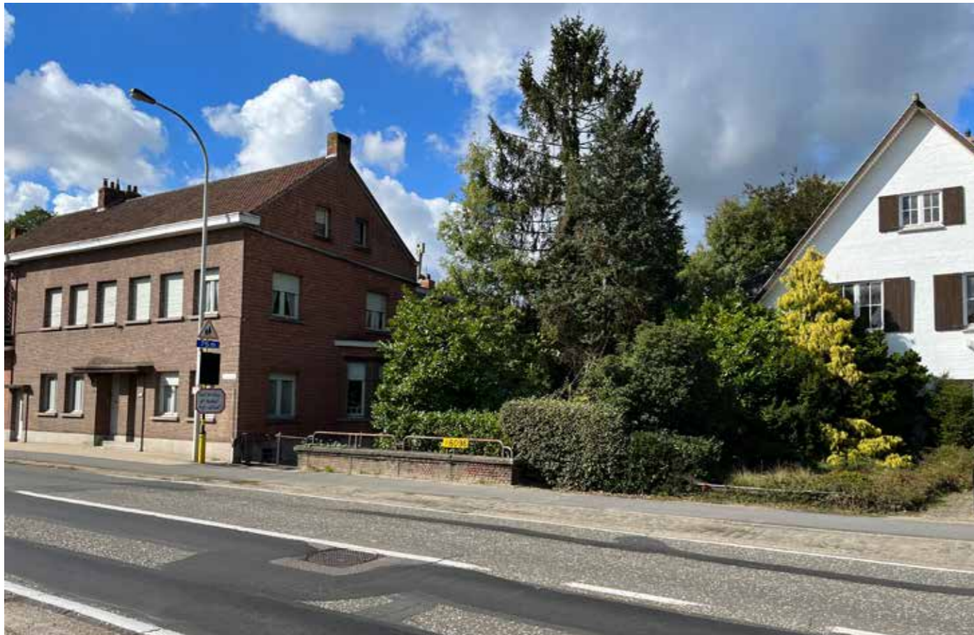
Bouwsesteenweg overbrugging Nijlense beek
