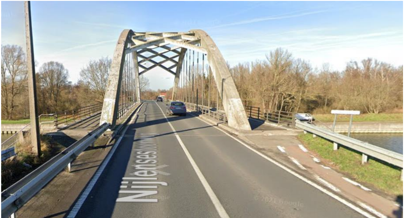
Figuur 3-8: Foto bestaande toestand (Mol-ter-Netebrug)
