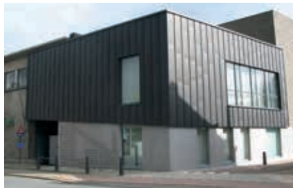
Het nieuwe administratieve gebouw aan het githo
